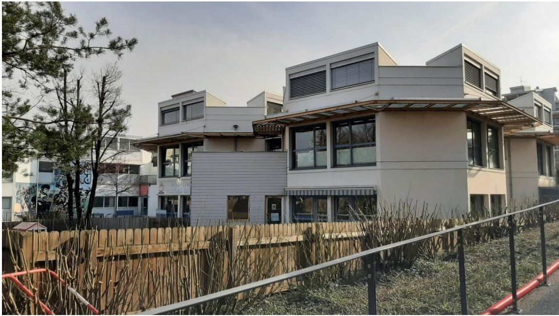
Maison Nelson Mandela et Petite enfance à Annemasse (Etat existant des façades)
