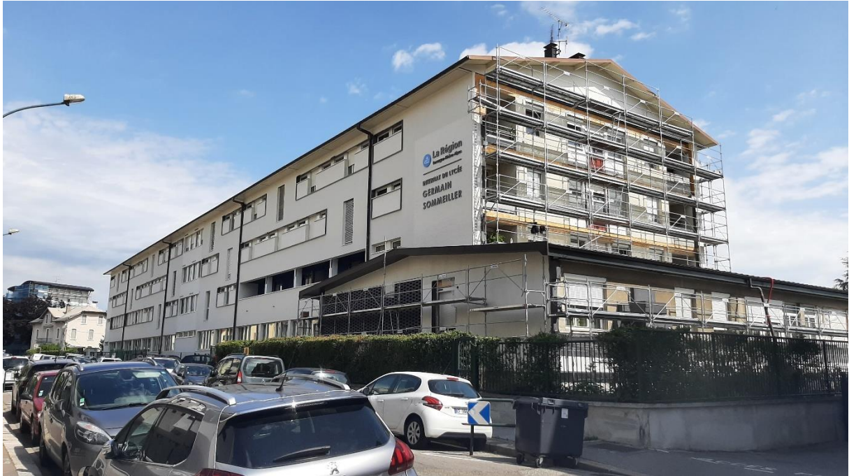
Internat du Lycée Germain Sommeiller à Annecy / Région Auvergne-Rhône-Alpes Réduction des consommations énergétiques de 40%
