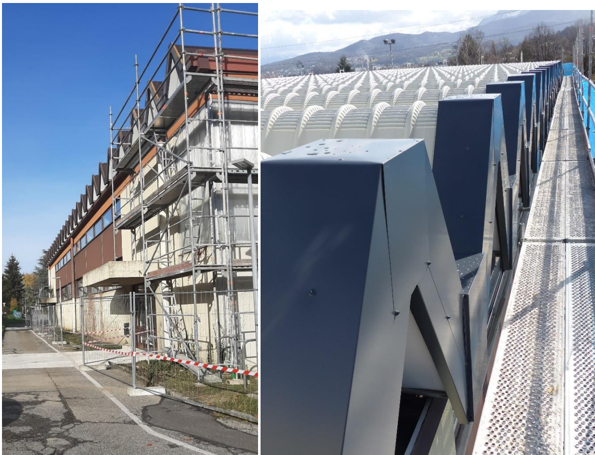
Gymnase Coubertin à La Motte Servolex Réduction des consommations énergétiques de 35%
