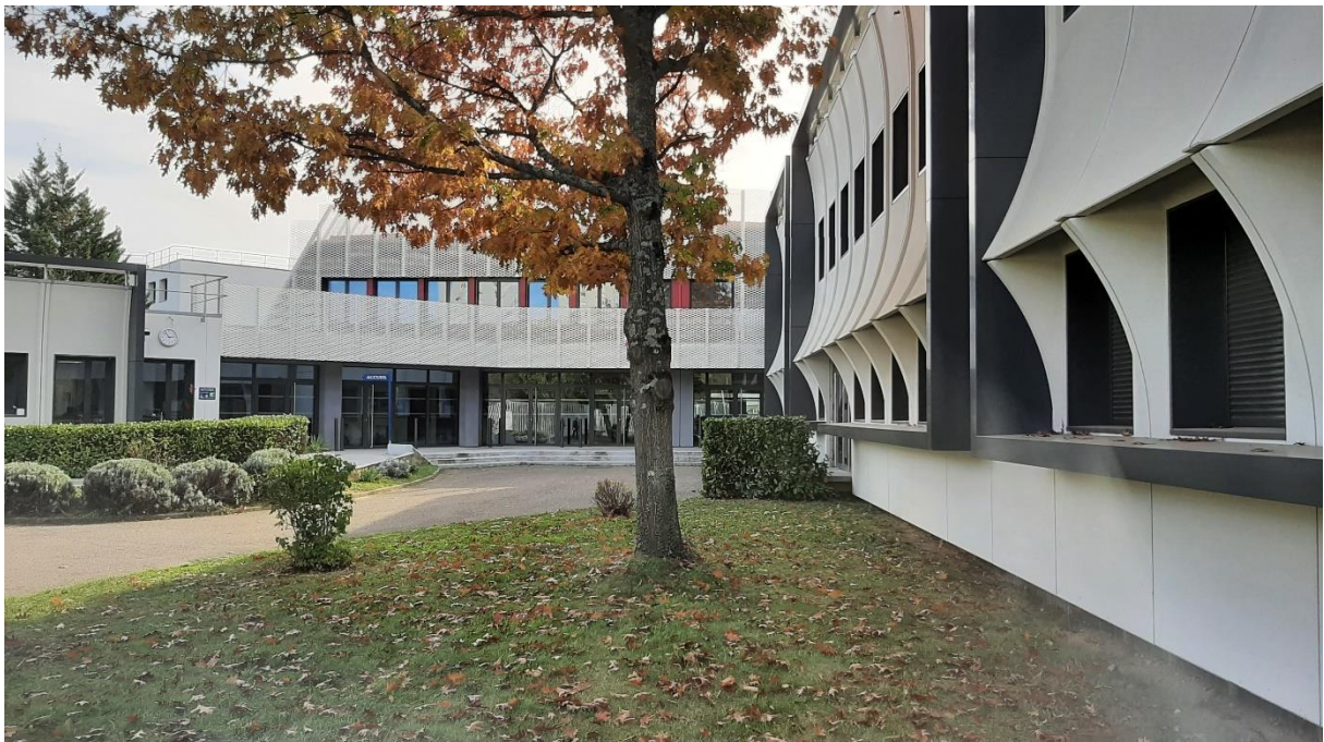
Lycée Fernand Forest à Saint-Priest / Région Auvergne-Rhône-Alpes Réduction des consommations énergétiques de 35%
