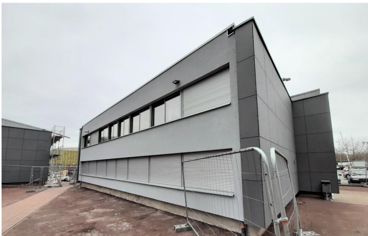
Internat du lycée La Fayette à Clermont-Ferrand / Région Auvergne-Rhône-Alpes Réduction des consommations énergétiques de 15% sur l'ensemble du site y compris les ateliers, l'imprimerie et la demi-pension (hors périmètre travaux)
