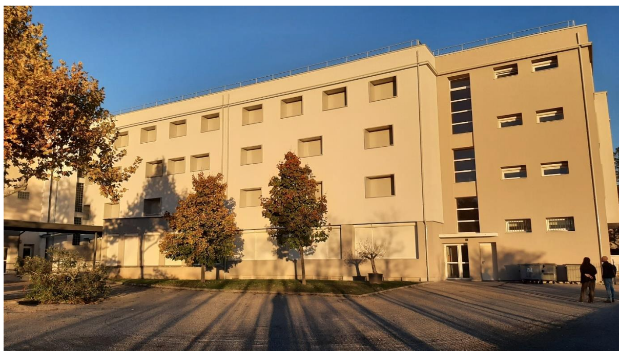
Lycée Albert Triboulet à Romans-sur-Isère pour la Région Auvergne-Rhône-Alpes Réduction des consommations énergétiques de 40% sur l'ensemble du site (une aile hors périmètre travaux)
