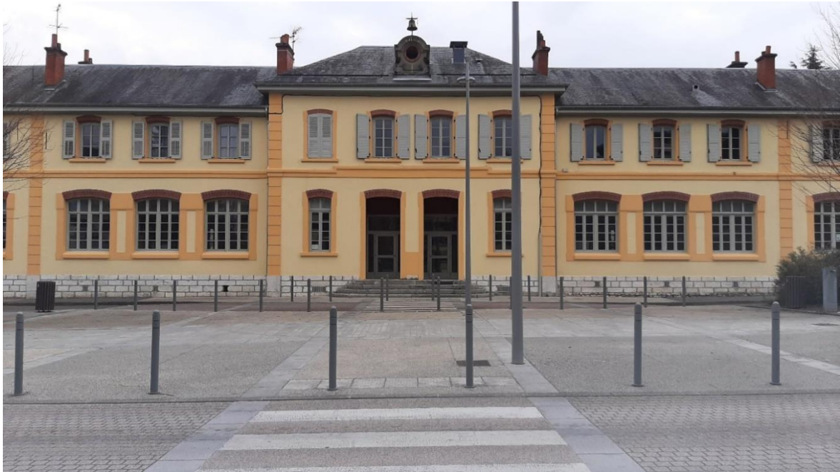
Ecole élémentaire Pergaud à La Motte Servolex Réduction des consommations énergétiques de 40%
