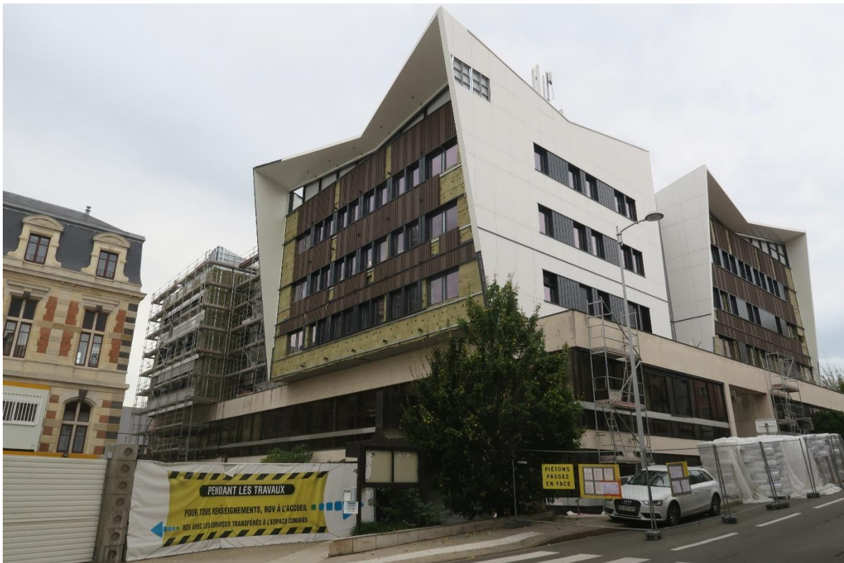
Bâtiment administratif Paul Pillet à Roanne Réduction des consommations énergétiques de 53%
